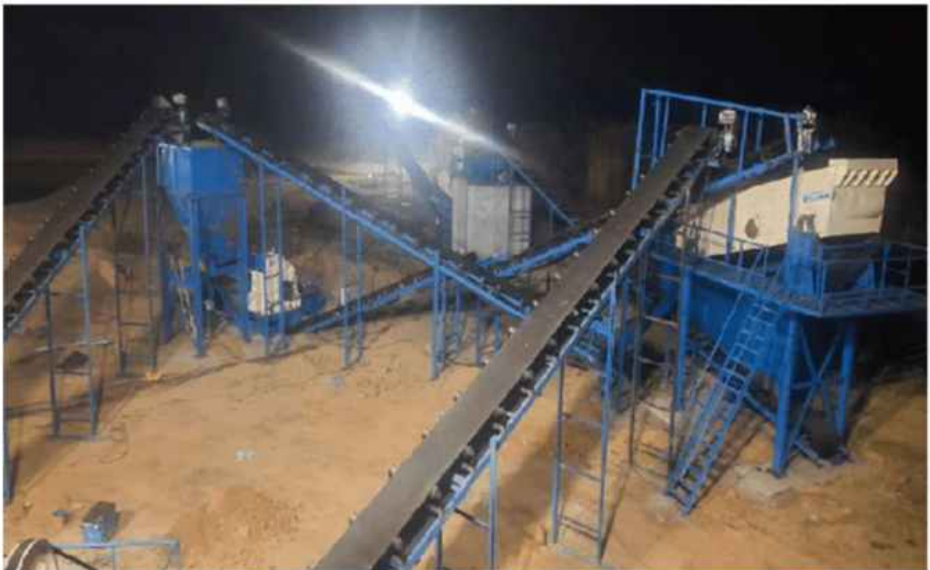
Kajora Plant, ECL
